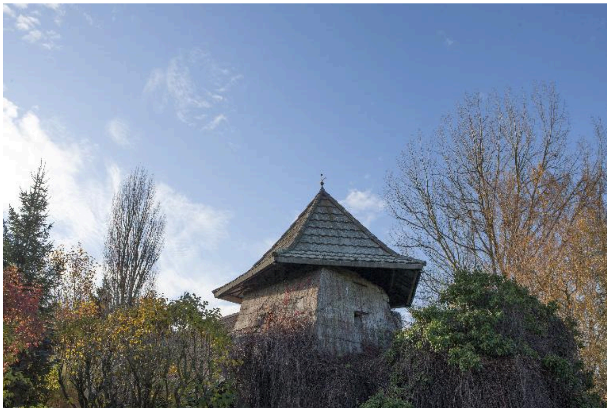
Sommet de l'observatoire, vers le nord-ouest
