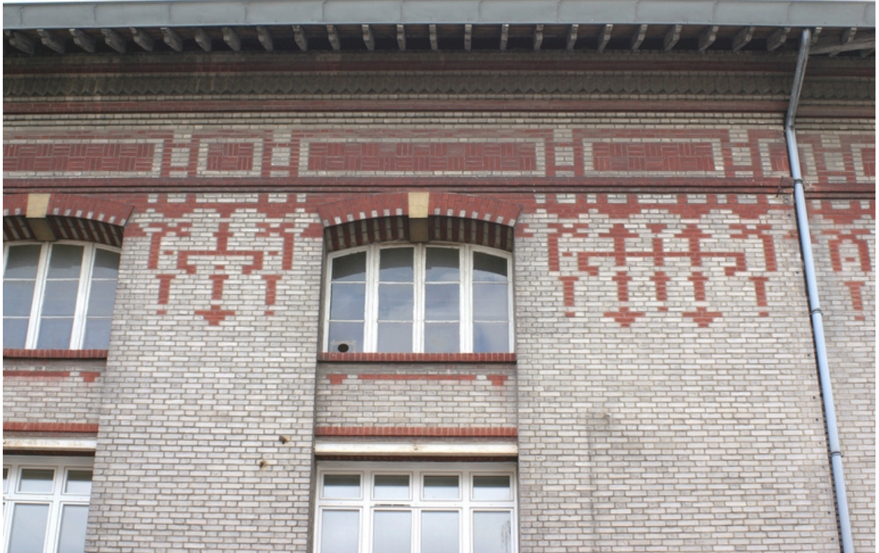
Détail de la façade, rue du Général Foy.
