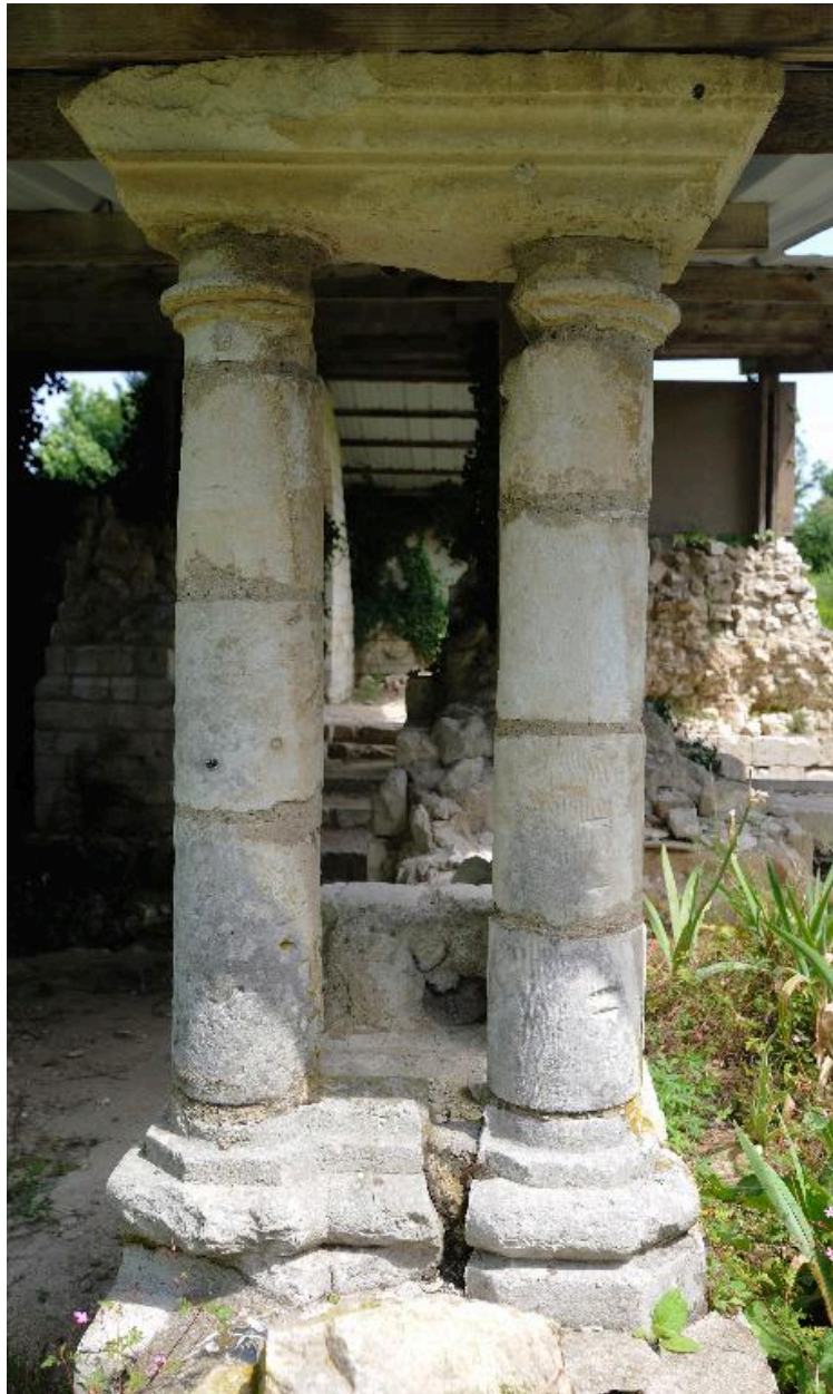
Reconstitution de colonnettes jumelées en bordure ouest du cloître.
