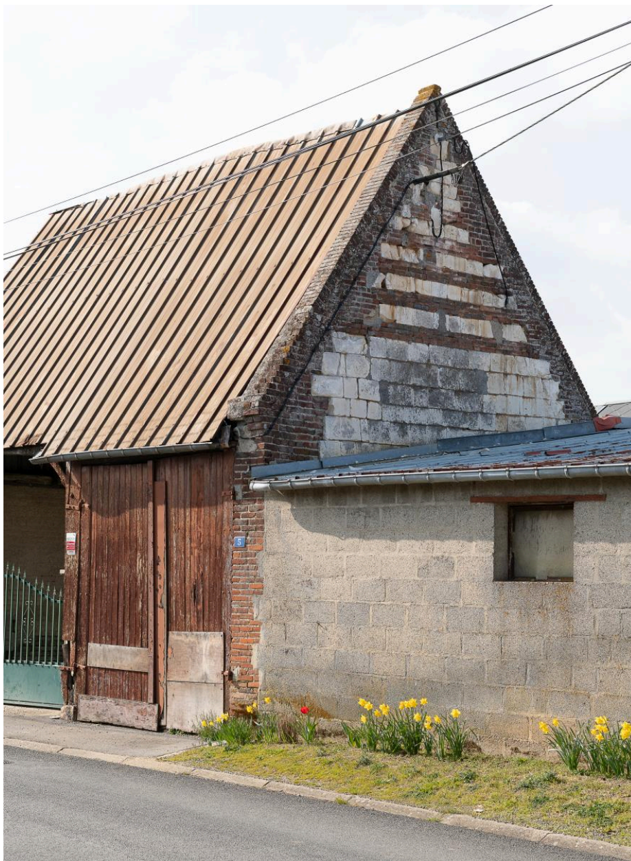
Mur coupe-feu en brique et pierre, n°5 rue de la Mairie, vue depuis l'est.
