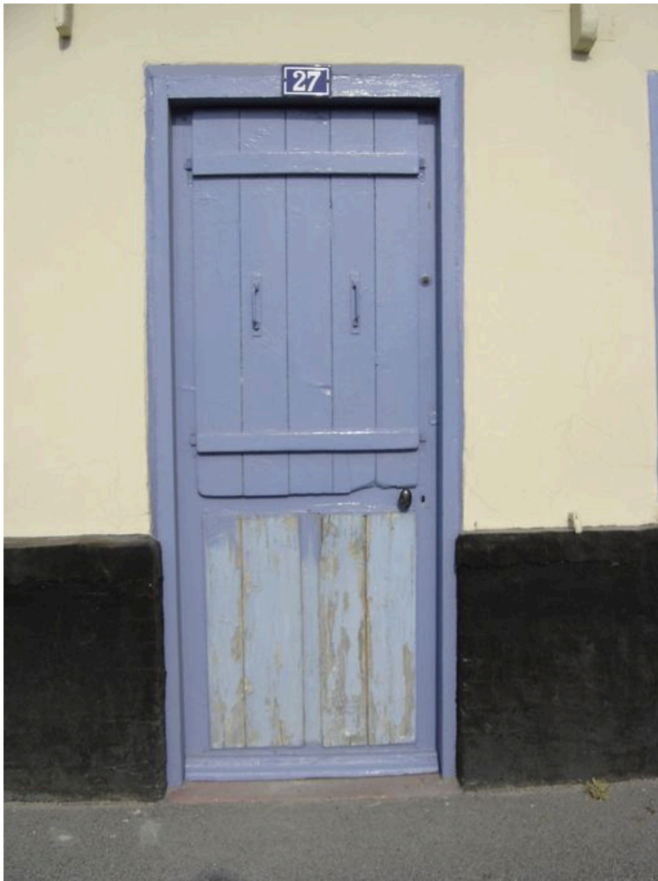
Vue détaillée de la porte.
