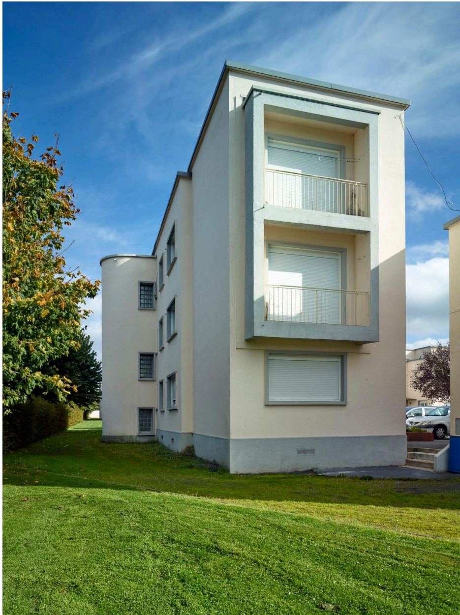
Vue latérale d'un immeuble collectif.
