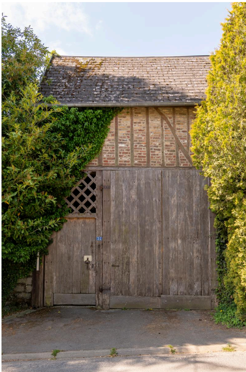
Détail de l'entrée charretière avec porte pitéonne et imposte ajourée, n°34 Grande Rue, vue depuis le nord-est.
