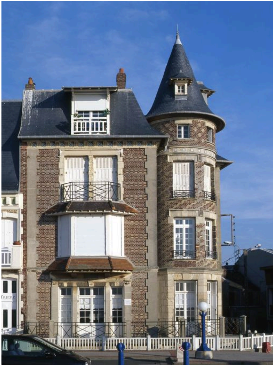
Elévation antérieure coté mer.
