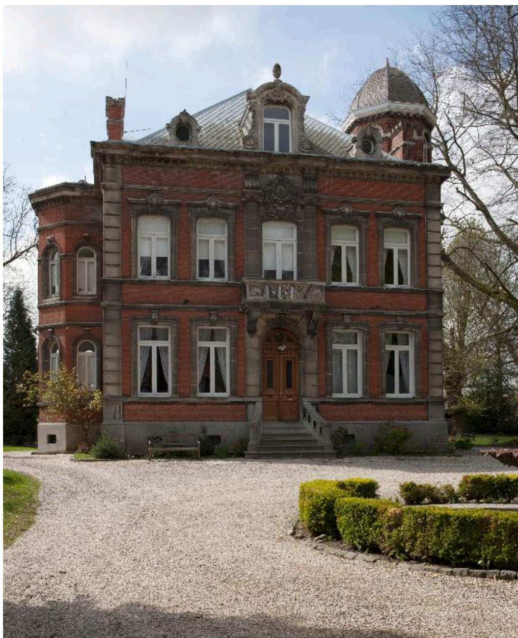
Maison de maître, 94, rue de Mortagne.
