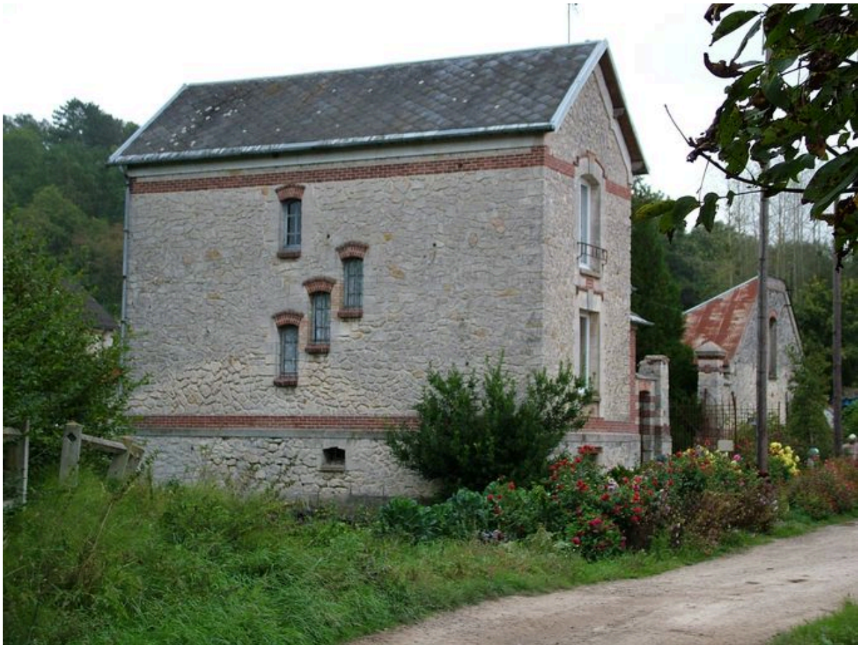
Vue latérale du logis.
