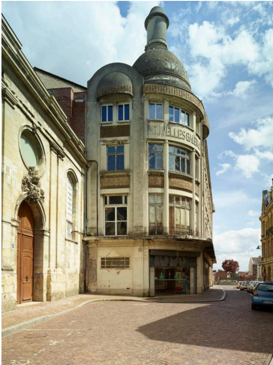
Angle nord-ouest des Nouvelles Galeries depuis la rue Saint-Jacques.
