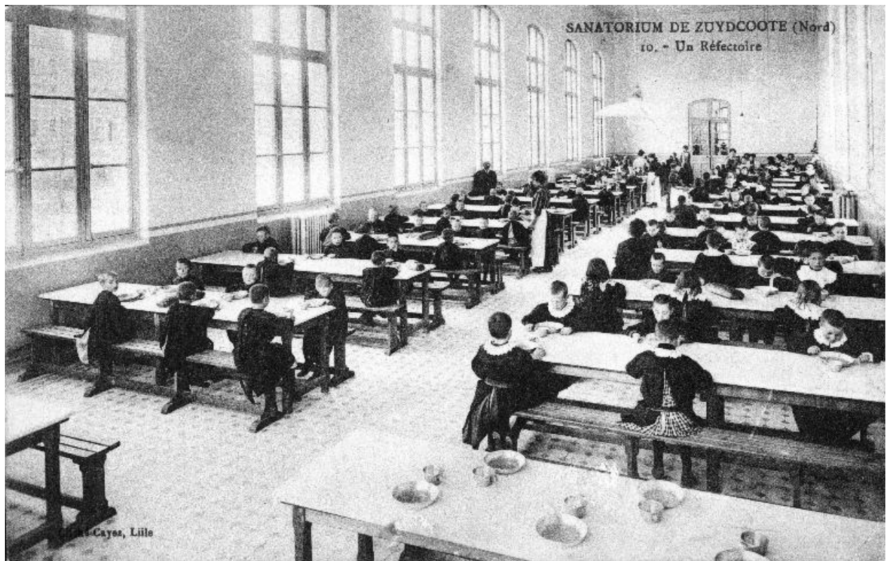
Bâtiment regroupant l'administration, les réfectoires et les services généraux, rez-de-chaussée, vue intérieure d'un des réfectoires prise pendant un repas, carte postale, début du 20e siècle (coll. part.).
