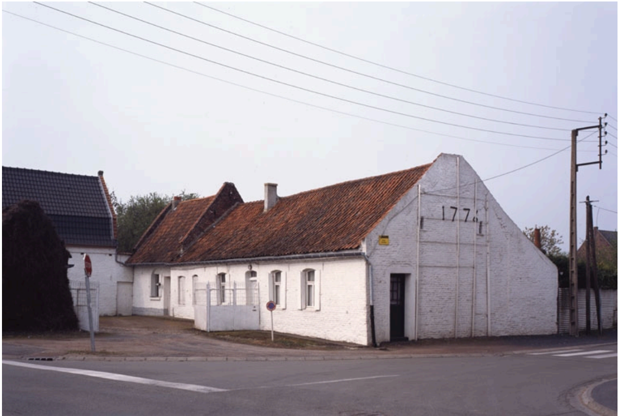
Vue partielle de la ferme située 64, rue du Moulin.
