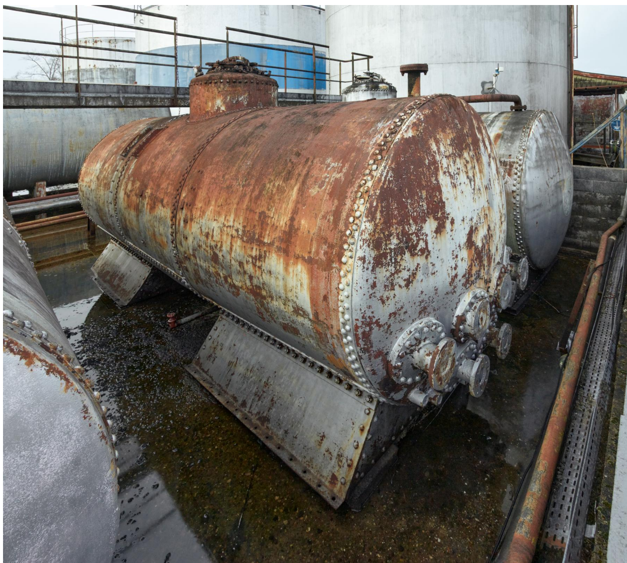
Cuves de stockage de produits chimiques.
