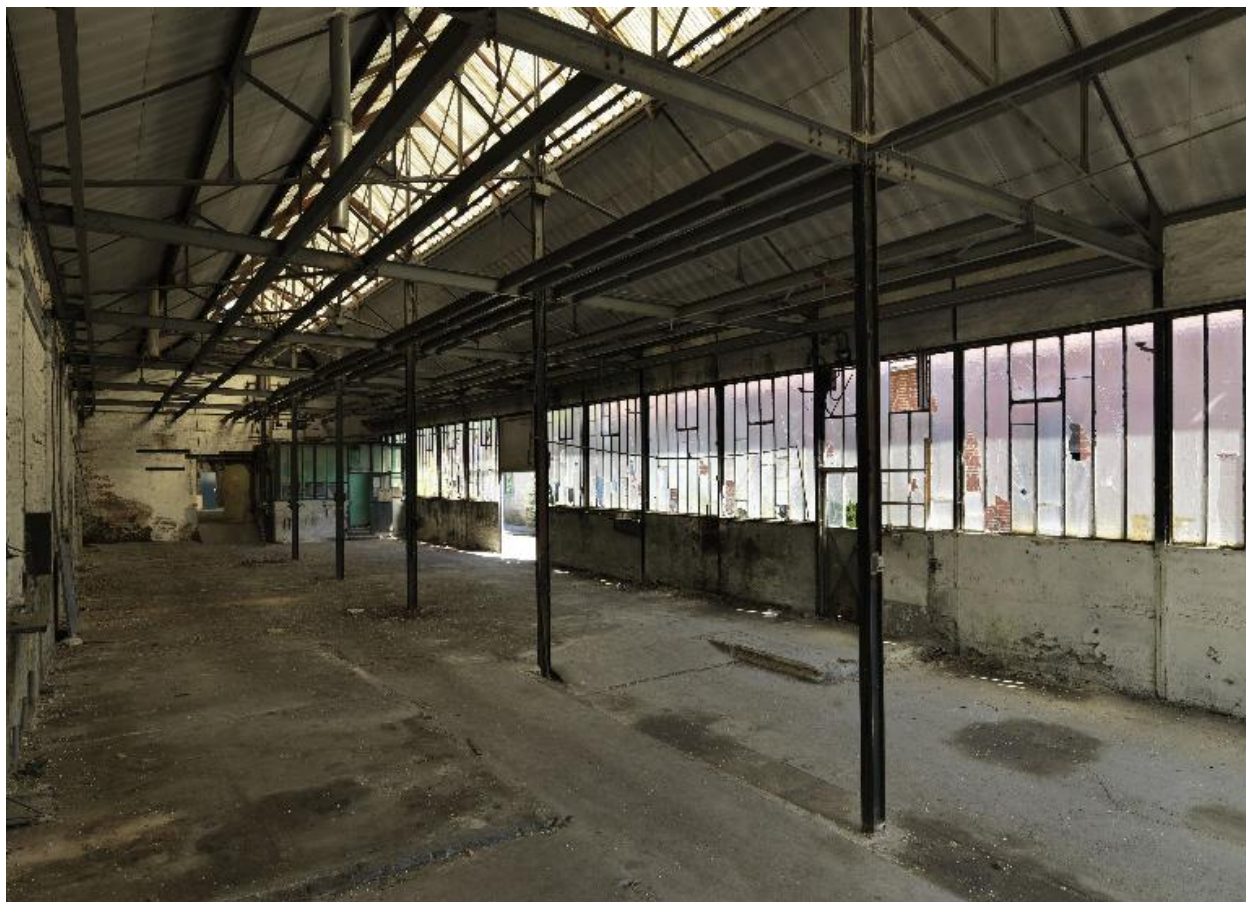
Vue intérieure des anciens ateliers de fabrication.
