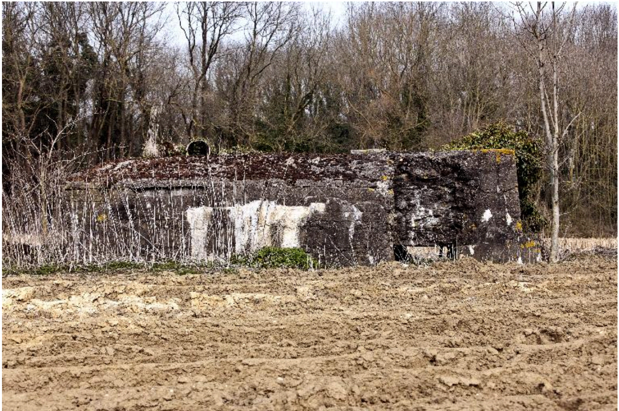
Vue générale vers le nord-est
