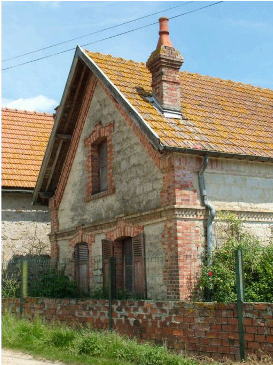
Détail du pignon sur rue de l'étable.
