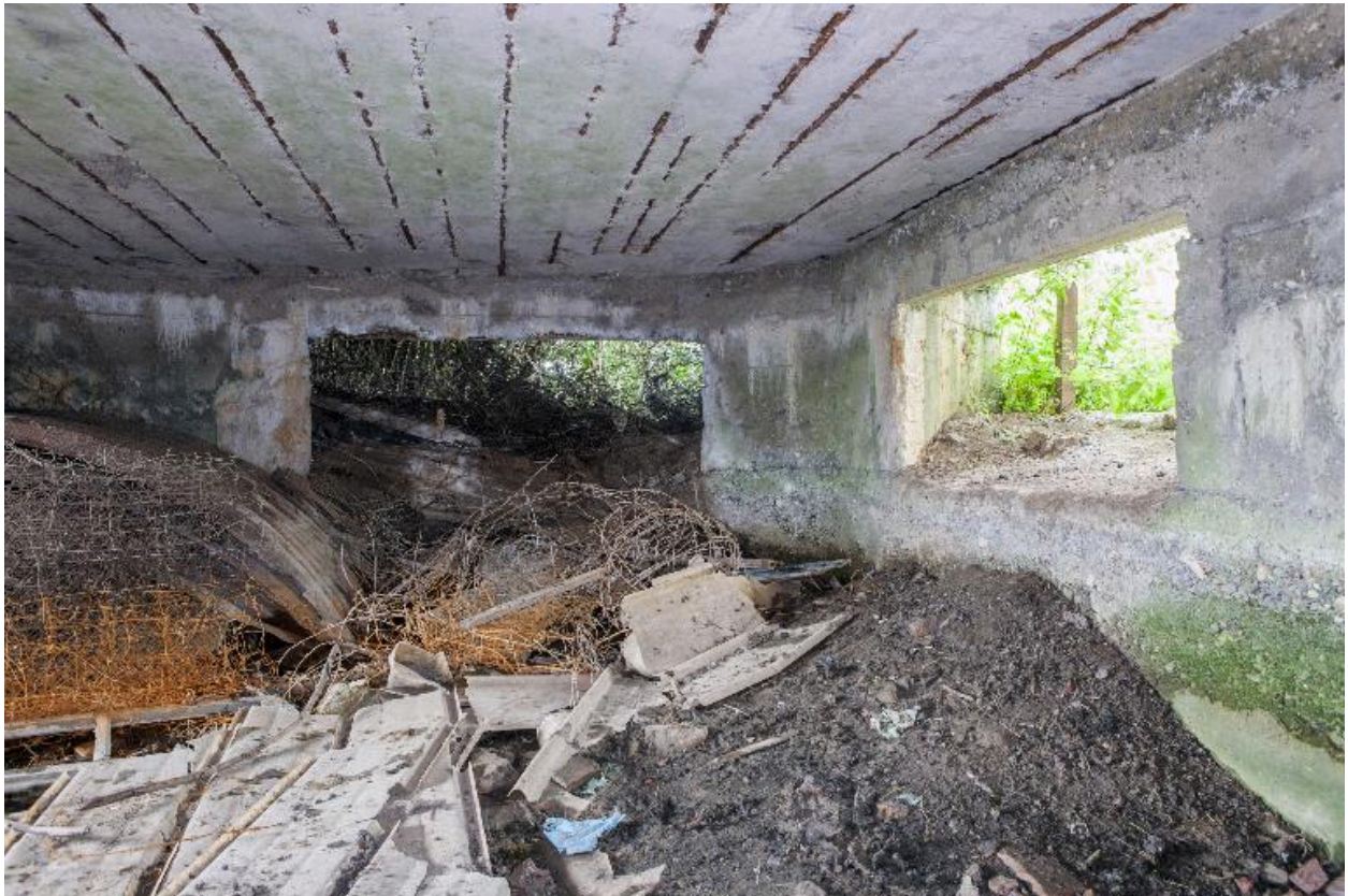
Vue intérieure de la chambre de tir vers le nord. Embrasures de tir
