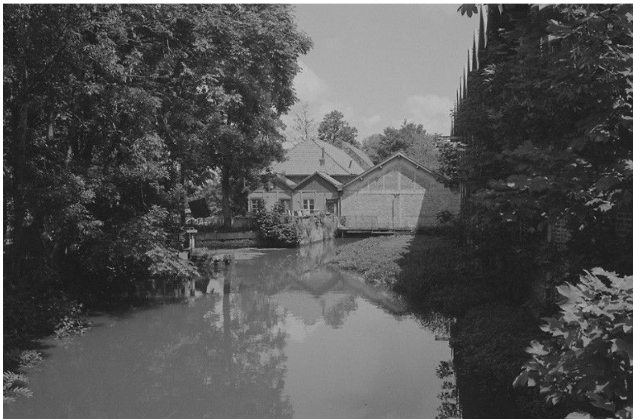
Bâtiment d'eau, flanc amont.
