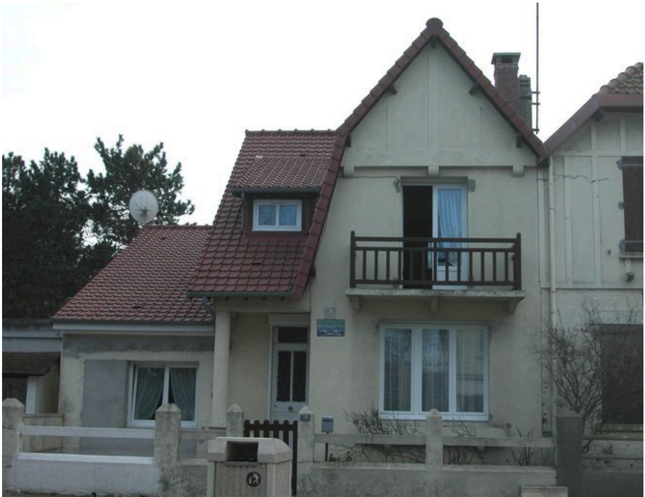
Les Brisants, élévation antérieure.
