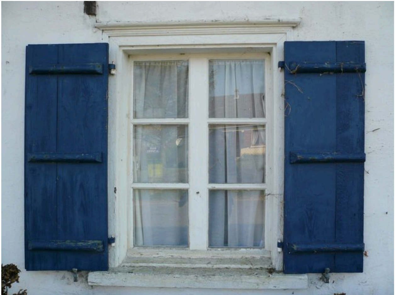
Vue détaillée d'un entablement de fenêtre.
