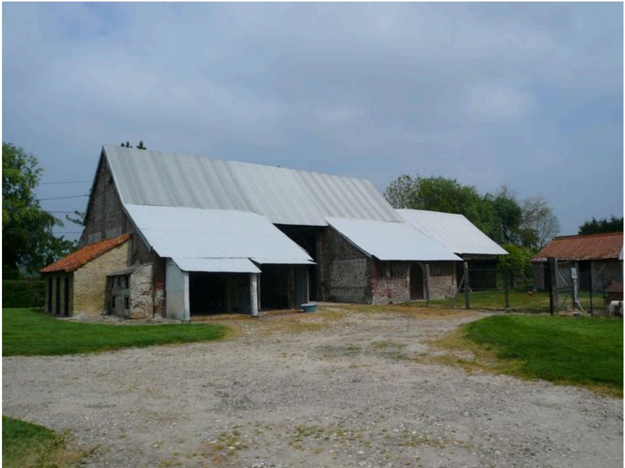
Vue de la grange depuis la cour.
