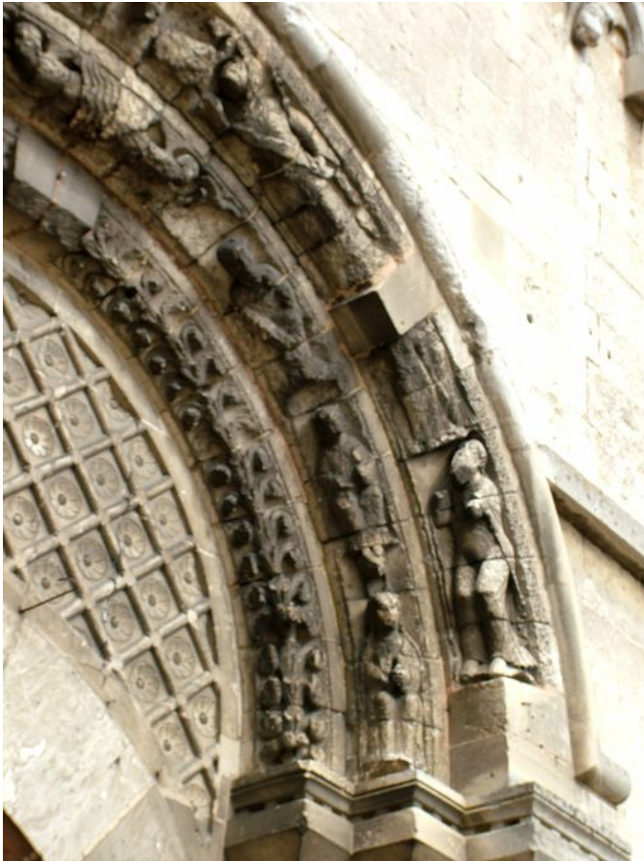
Détail de la voussure du portail occidental : partie droite.
