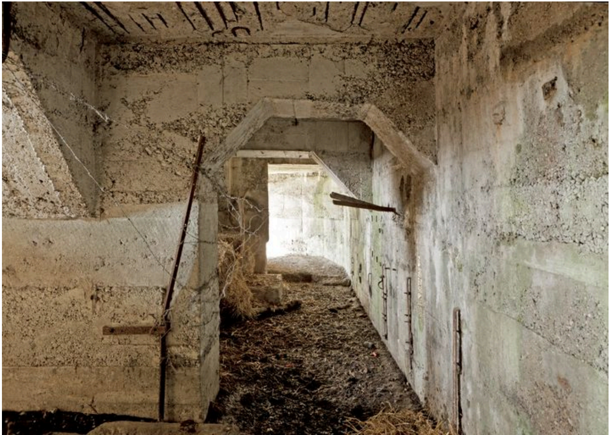
Couloir, vers l'ouest
