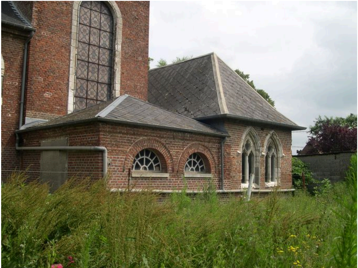
Vue des sacristies depuis le sud-ouest.
