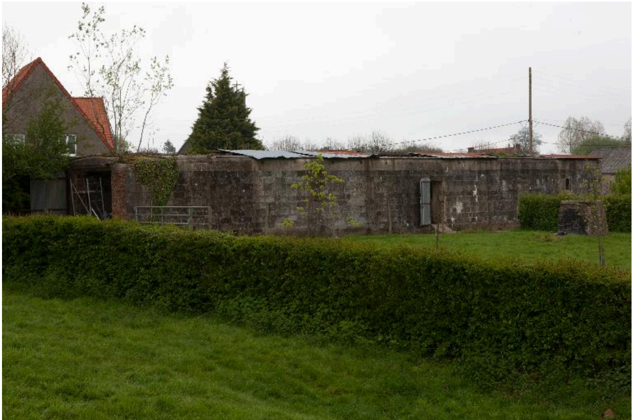
Bâtiment de stockage d'attente. Vue générale.
