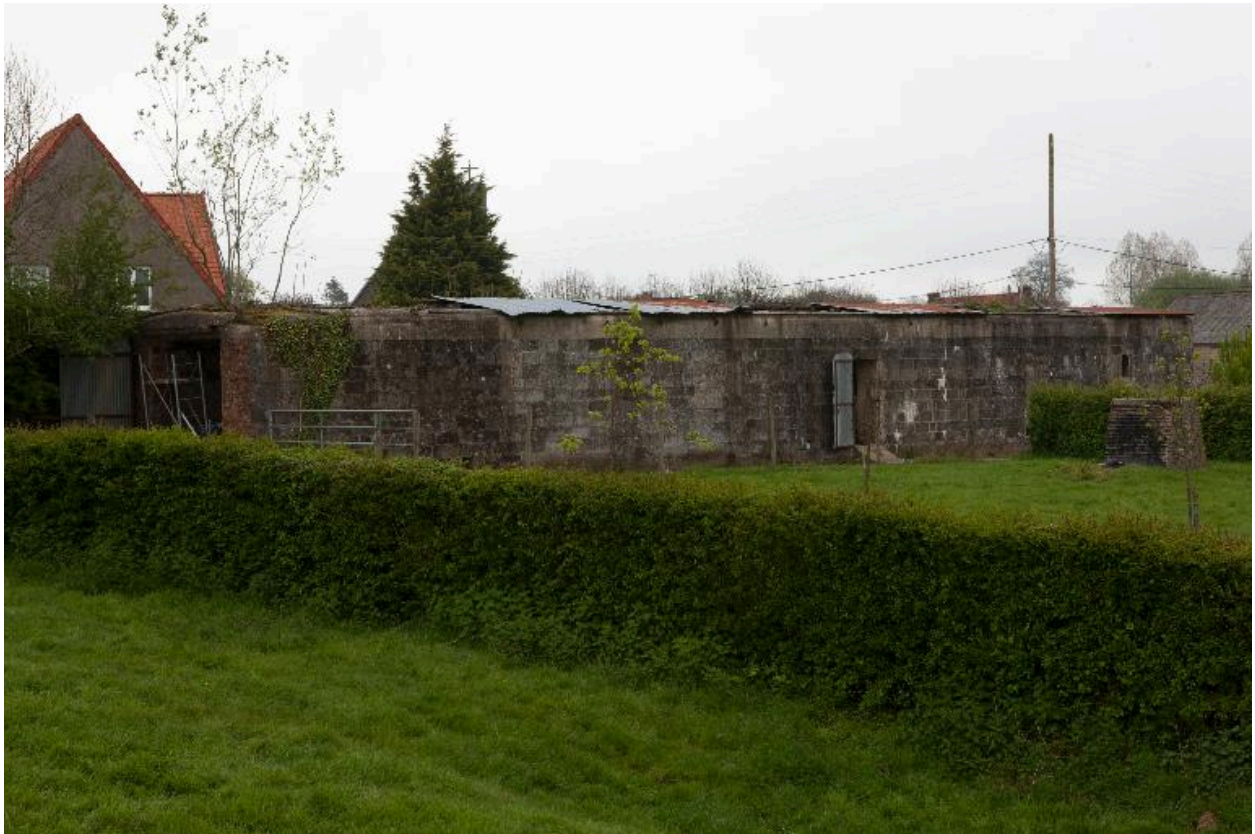
Bâtiment de stockage d'attente. Vue générale.
