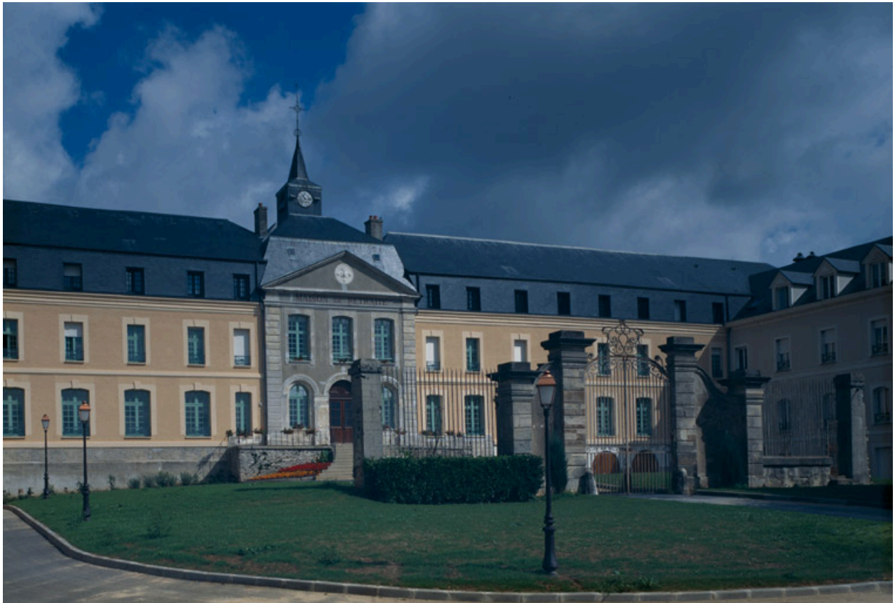
La grille d'entrée.
