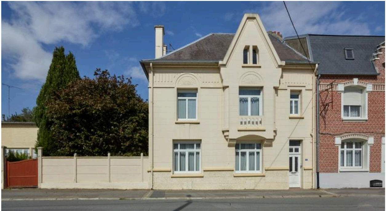
Vue générale de la façade depuis la rue de Douai.
