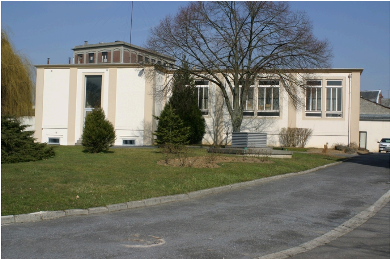
Ancienne salle des machines (à droite) et ancienne chaufferie (à gauche).
