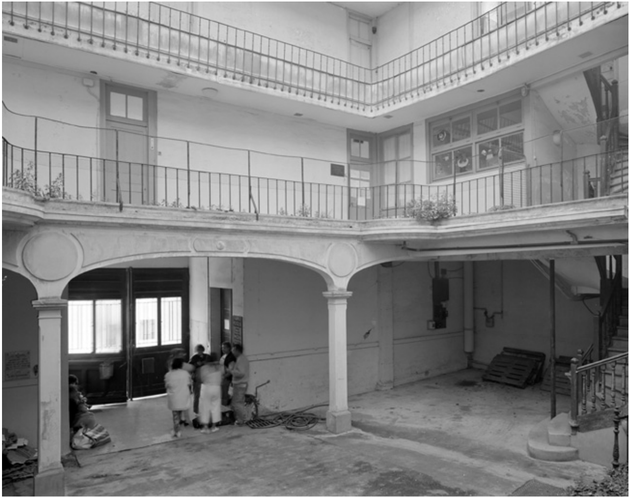
Elévation sur la cour.
