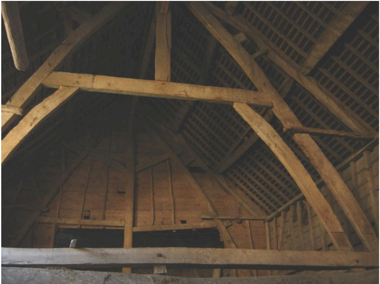
Vue d'une ferme de charpente de la grange.
