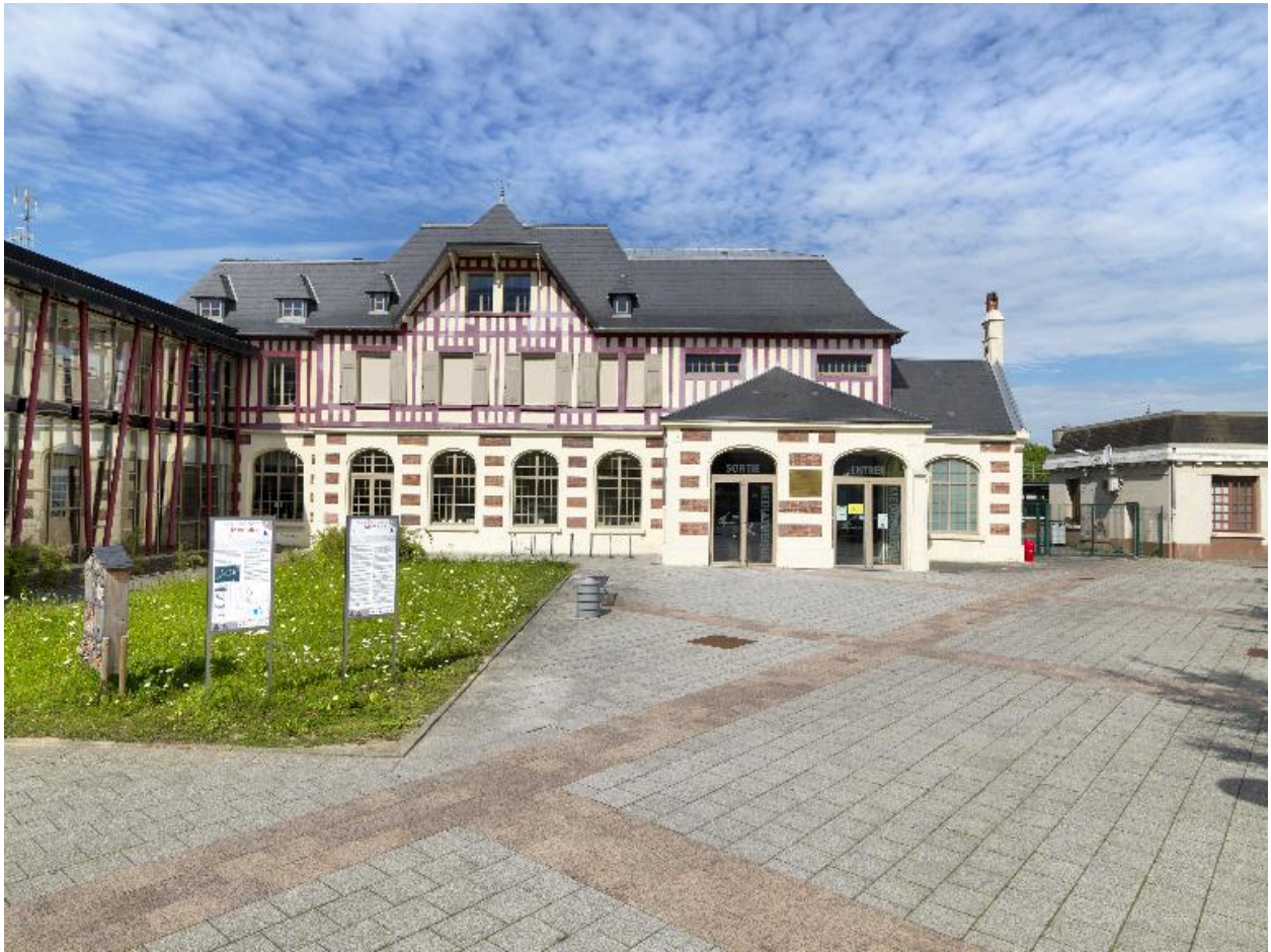
Vue générale de l'ancien buffet de la gare.
