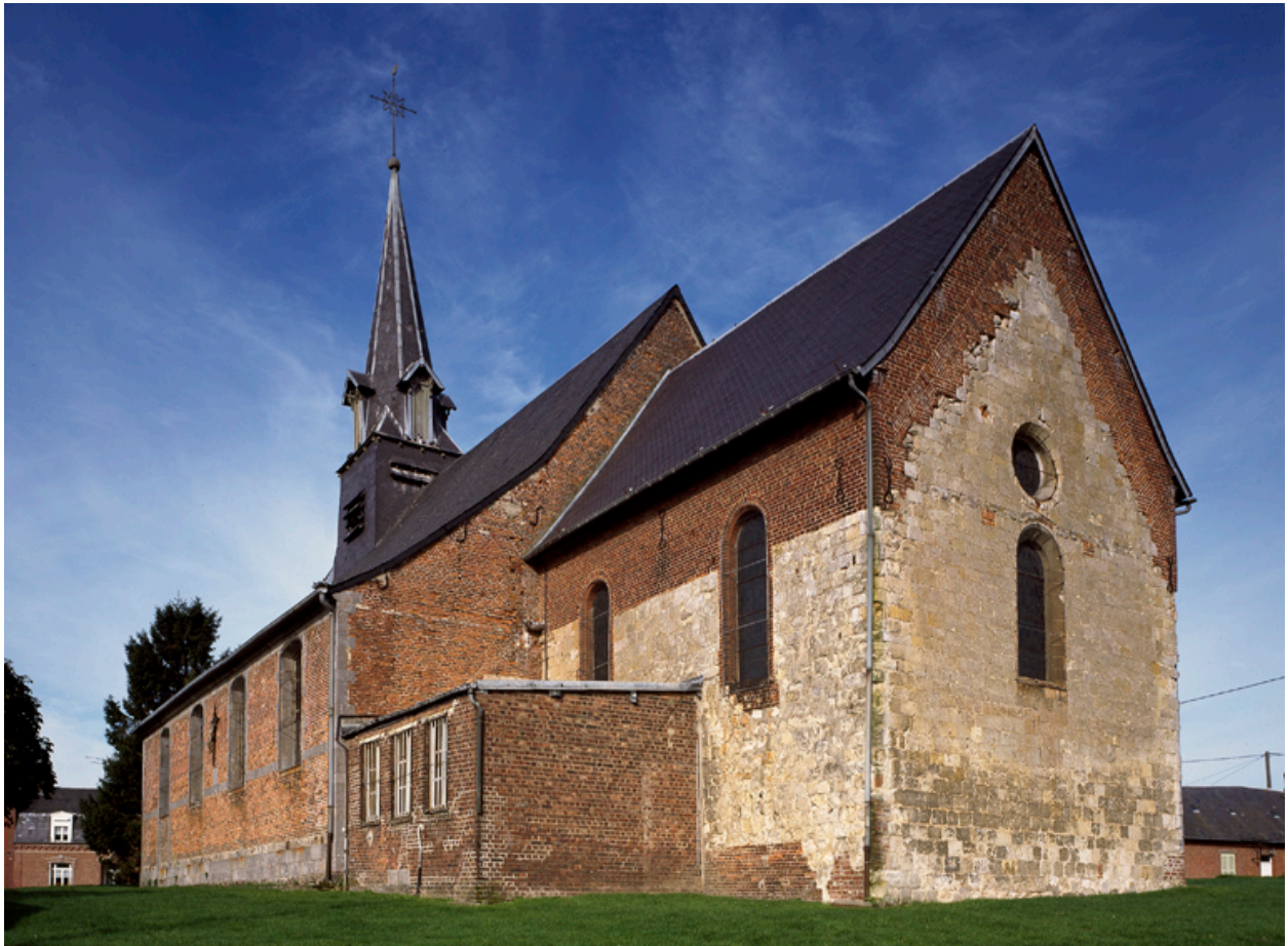
Vue générale, depuis l'est.
