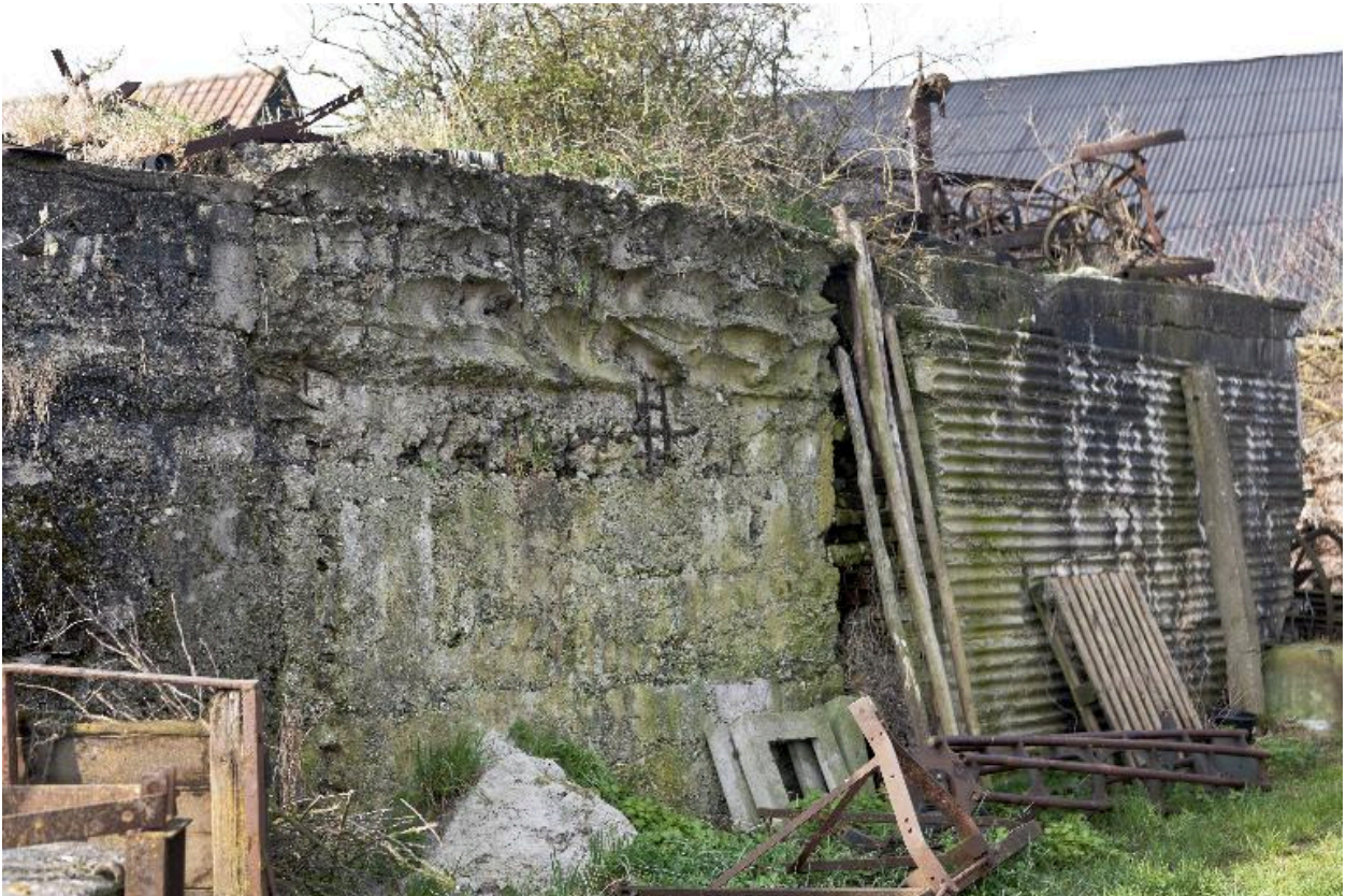
Elévation nord : empreintes de coffrages en tôles ondulées et sacs de sables
