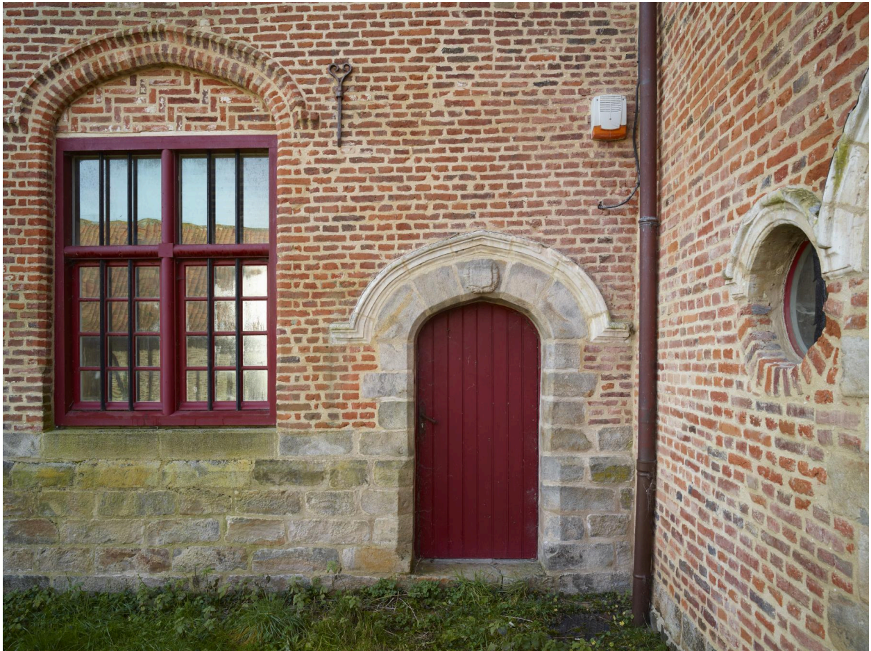
Porte d'accès principale au logis du XVIIIe siècle.
