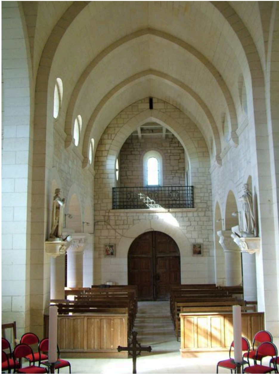
Vue intérieure de la nef.
