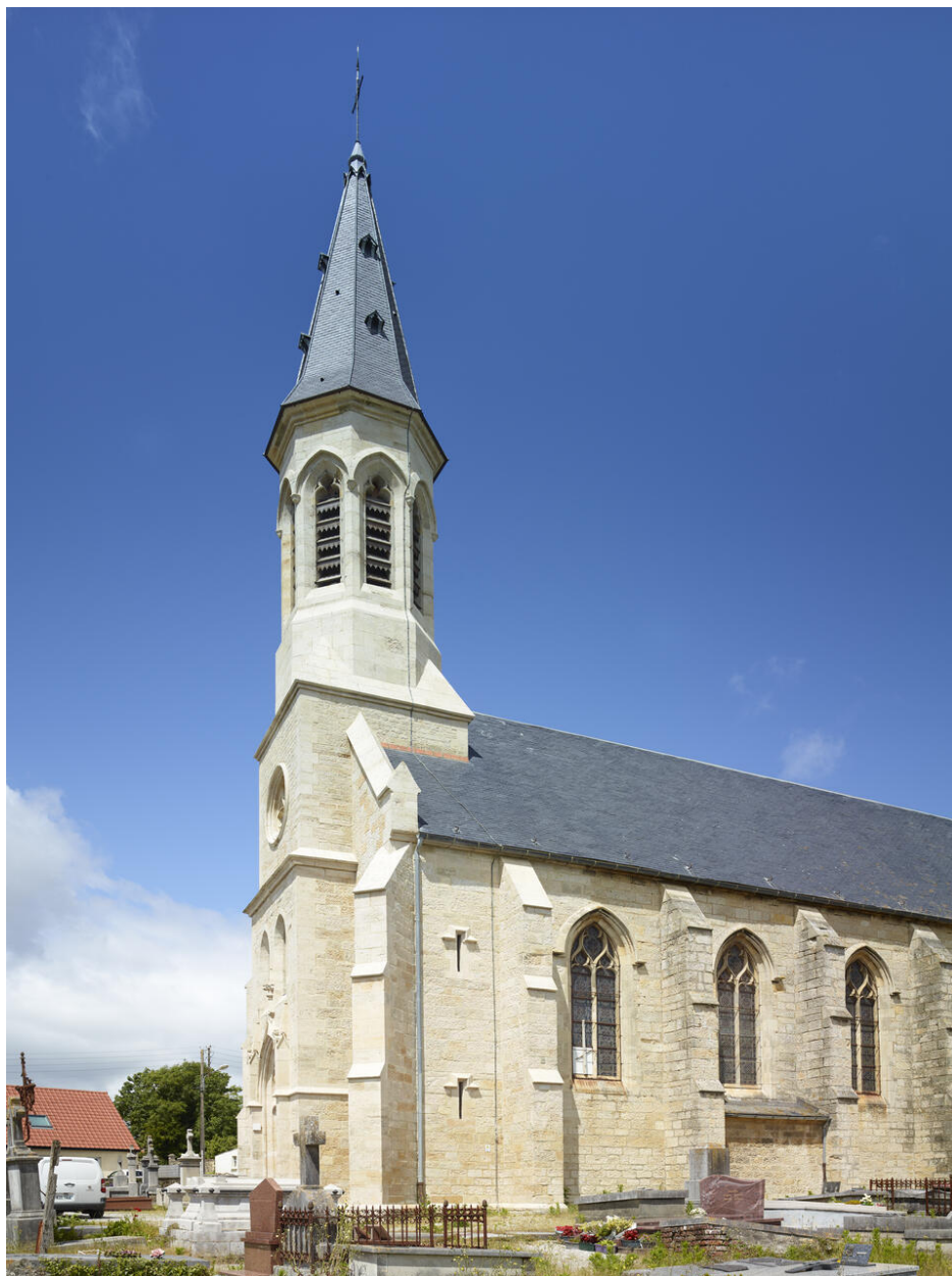
Vue générale du clocher depuis le sud.
