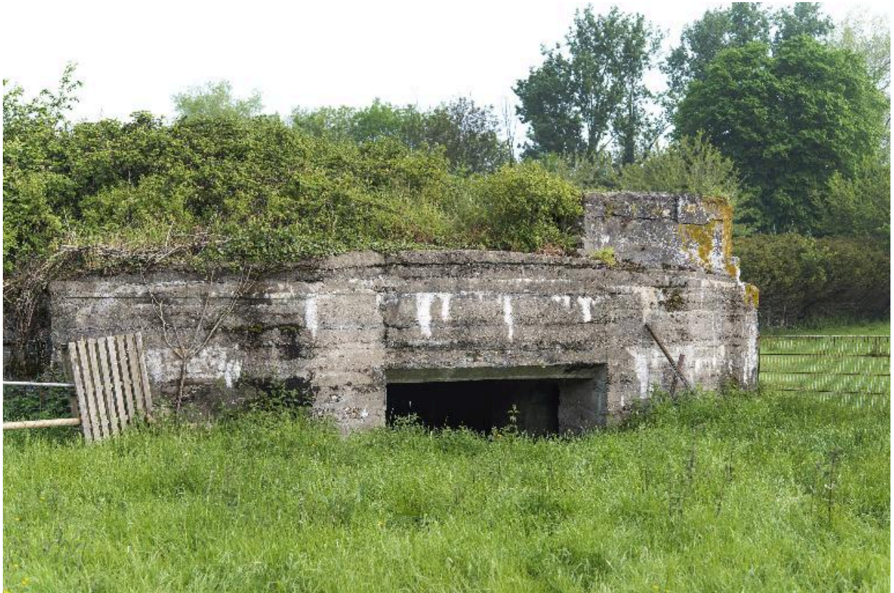
Elévation sud, entrée pour l'artillerie et poste d'observation, à droite sur le couverture
