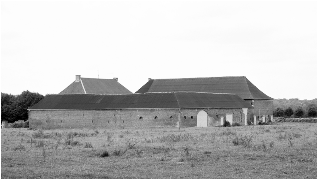
Vue générale de la ferme depuis le nord-est.
