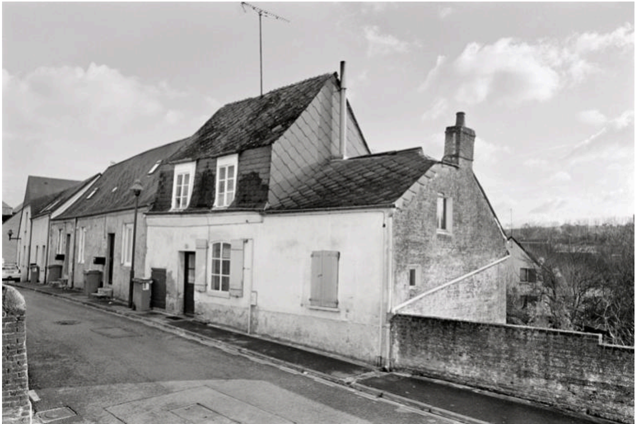
Vue de la façade sur rue.
