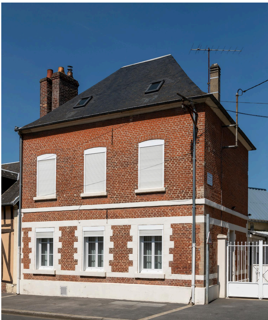
Ancienne gendarmerie, n°12 rue de Beauvais, vue depuis le sud-est.
