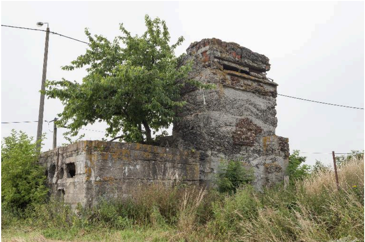
Tour d'observation casematée a, vers le sud-ouest
