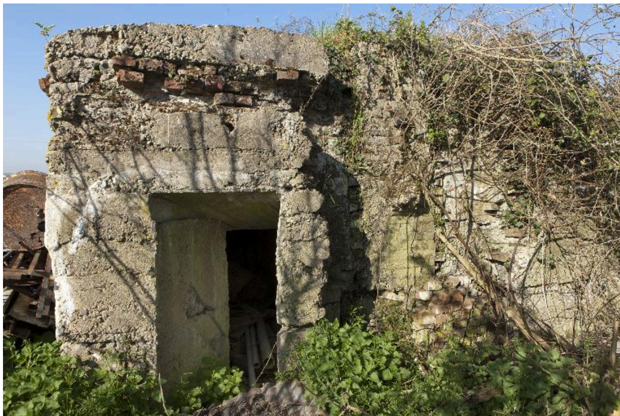
Casemate B, entrée sur l'élévation est
