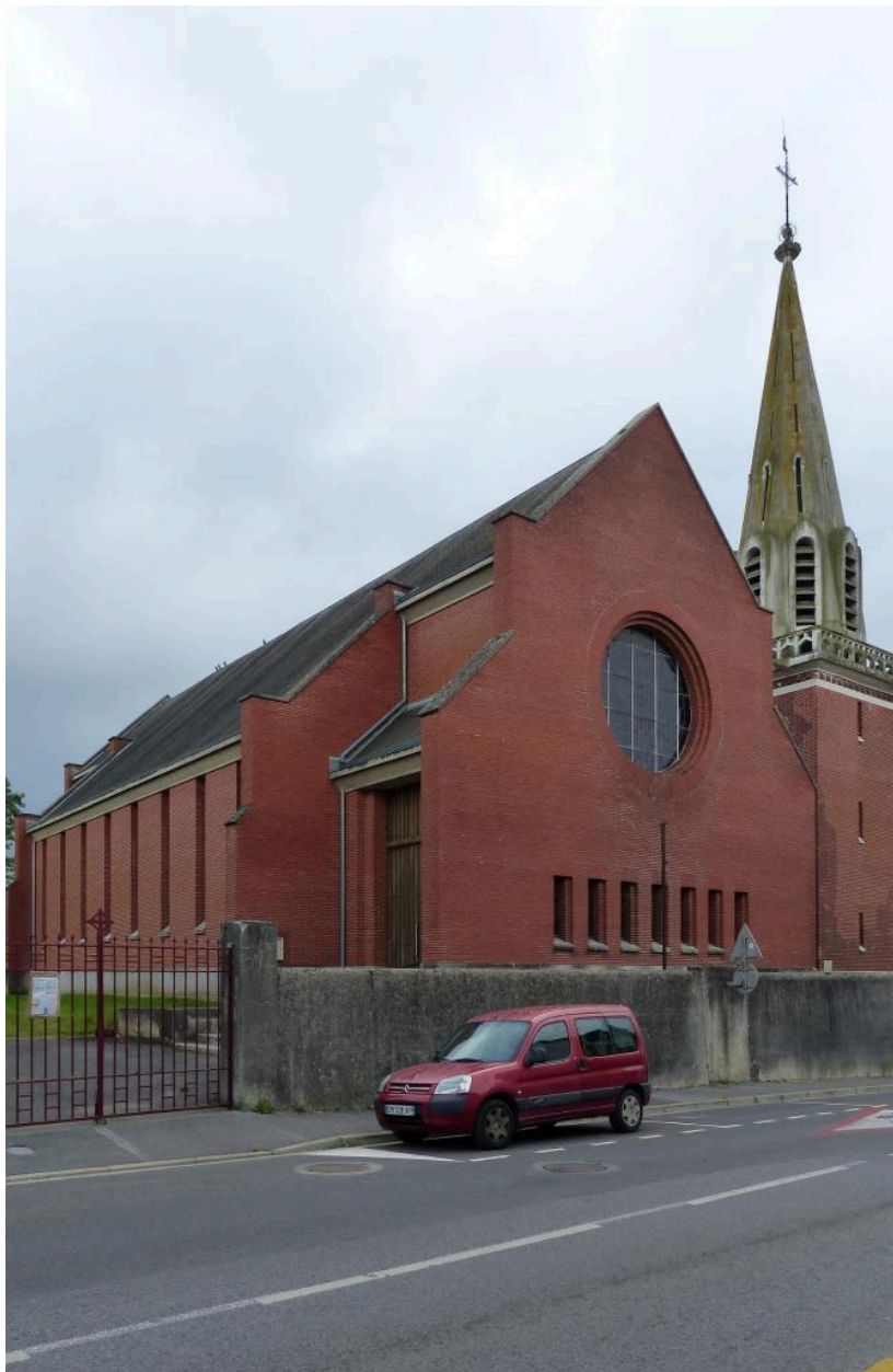
Vue générale, depuis le nord.
