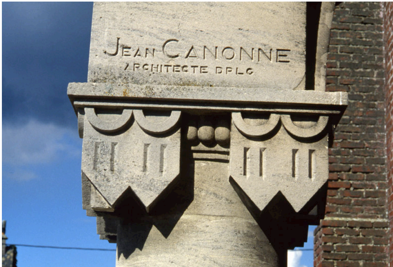
Détail d'un chapiteau du porche de l'église, portant la signature de Jean Canonne, architecte de l'église reconstruite entre 1929 et 1931.
