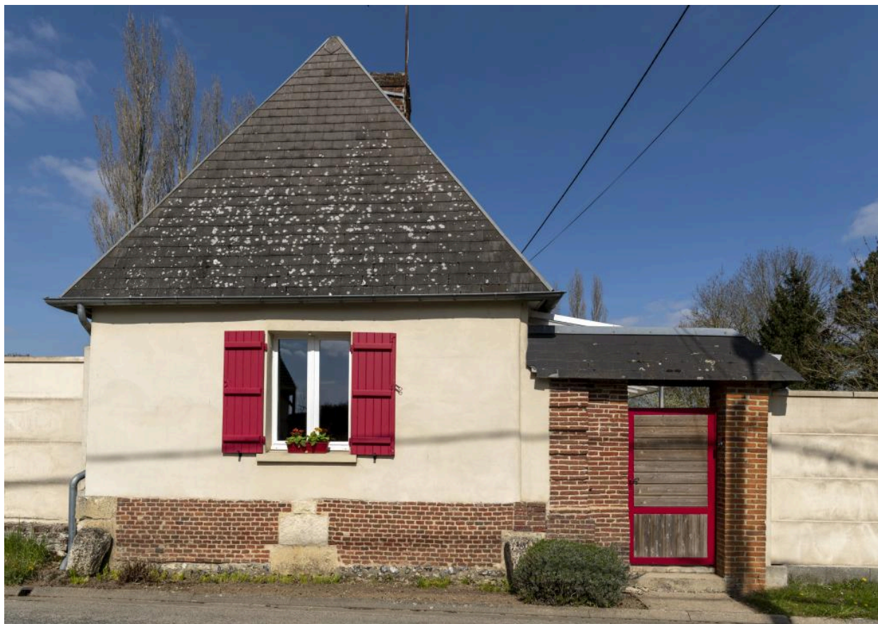
Pignon de logis sur rue, n°10 rue Principale, vue depuis l'ouest.
