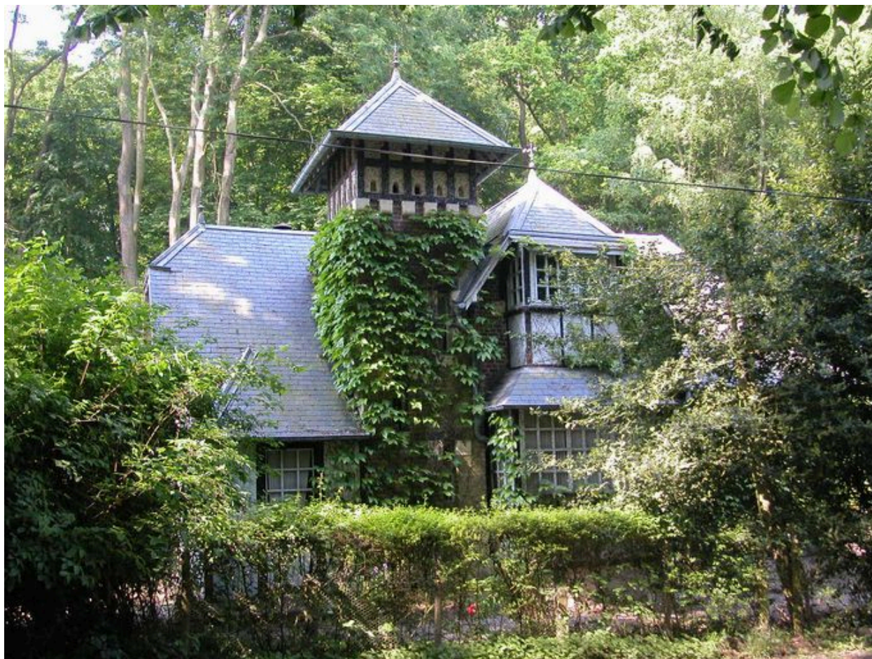
Vue d'ensemble depuis la route du Vieux-Chêne.
