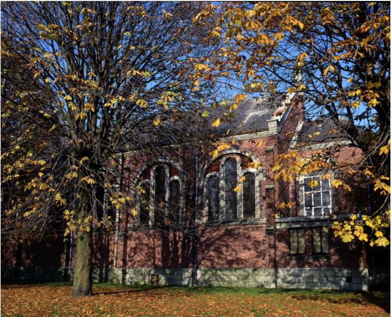
Vue générale de la façade sud.
