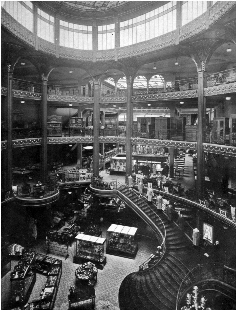
Vue de l'atrium ovale et du grand escalier entre 1927 et 1934 (Cité de l'Architecture et du Patrimoine ; fonds des Bétons armés Hennebique ; 3-D-364-c).
