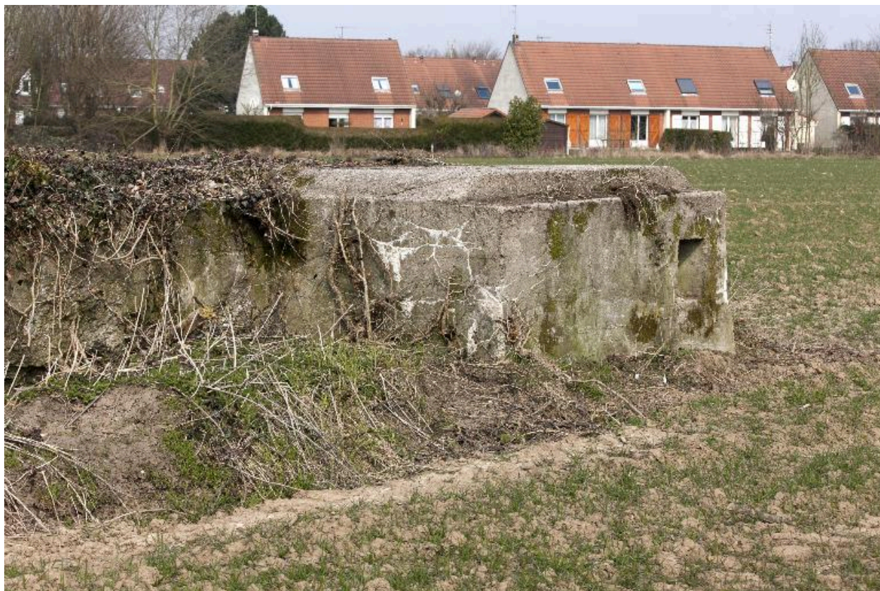
Détail de l'ouvrage en L précédent.
